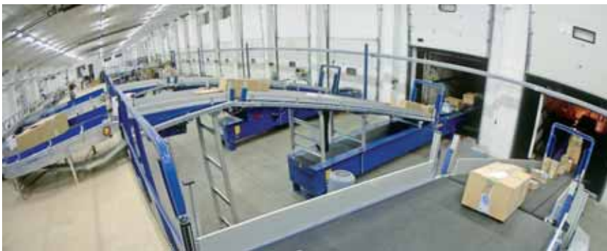
Leistung mit Reserven: Bis zu 7000 Pakete pro Stunde schafft die vollautomatische Sortieranlage im neuen Paket-Hub von General Parcel Cechy.
