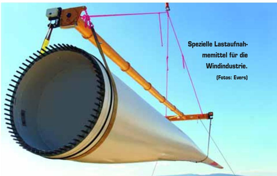
Spezielle Lastaufnahmemittel für die Windindustrie.
